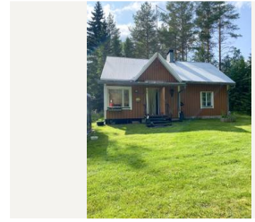
Päärakennus idän suunnasta
