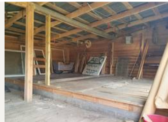
kellari aitan ullakko
