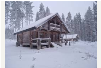
pää- ja varastorakennus etelästä
