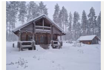
pää- ja varastorakennus kaakosta
