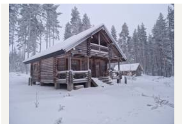
pää- ja varastorakennus etelästä
