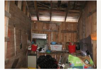
Varasto navetan päädysssä
